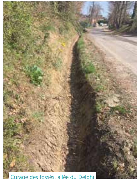
Curage des fossés, allée du Delphi
