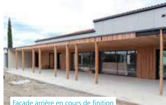
Façade arrière en cours de finition
