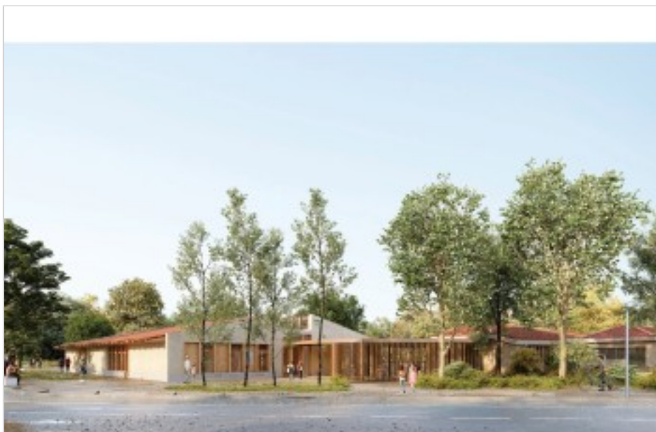
VUE DE LA FAÇADE PRINCIPALE DEPUIS LE PARVIS DE L'ÉCOLE
